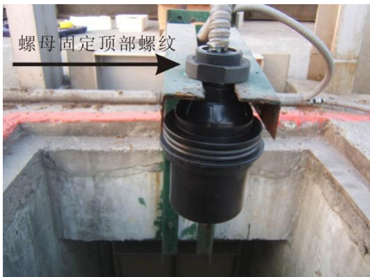
①在探头顶部螺纹用螺母固定
